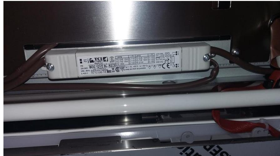
Remove the lamps; if necessary, replace the ballast / Rimuovere le lampade; se necessario, sostituire il trasformatore per il neon
