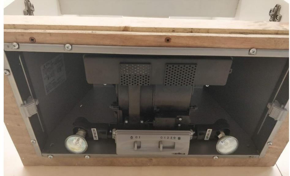
Press the lateral spring to remove the down panel / premere le molle laterali per rimuovere la cappa
